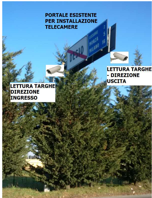
Foto 1 – Posizionamento apparati e direzioni di lettura
