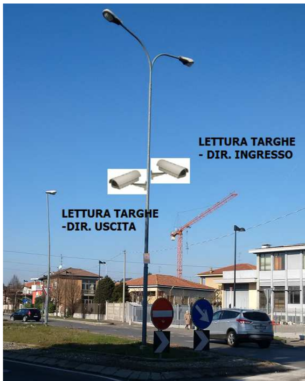
Foto 8 – Posizionamento apparati e direzioni di lettura
