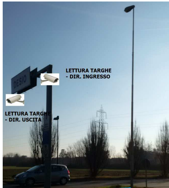
Foto 12 – Posizionamento apparati e direzioni di lettura
