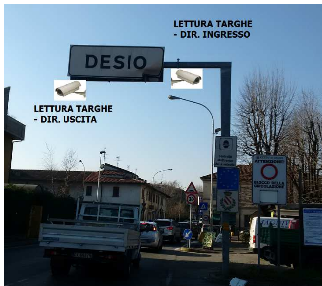
Foto 15 – Posizionamento apparati e direzioni di lettura
