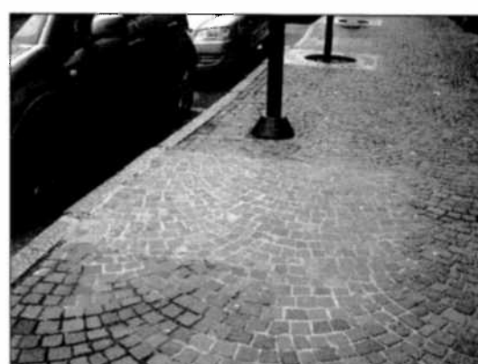
Ripristino pavimentazione in porfido
