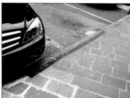
Sigillatura fughe per impedire infiltrazioni autorimesse sottostanti
