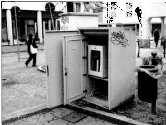
Armadio apparecchi diffusione sonora
